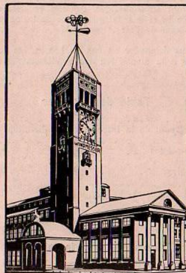
Anémomètre installé par la maison FUESS au musée allemand à Munich. La direction et la force du vent sont visibles de loin sur le cadran de 5 m de diamètre.
